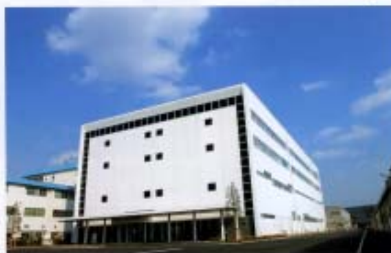
2006年、UD研究所が夢っ橋PGDセンター内に設立されました。
