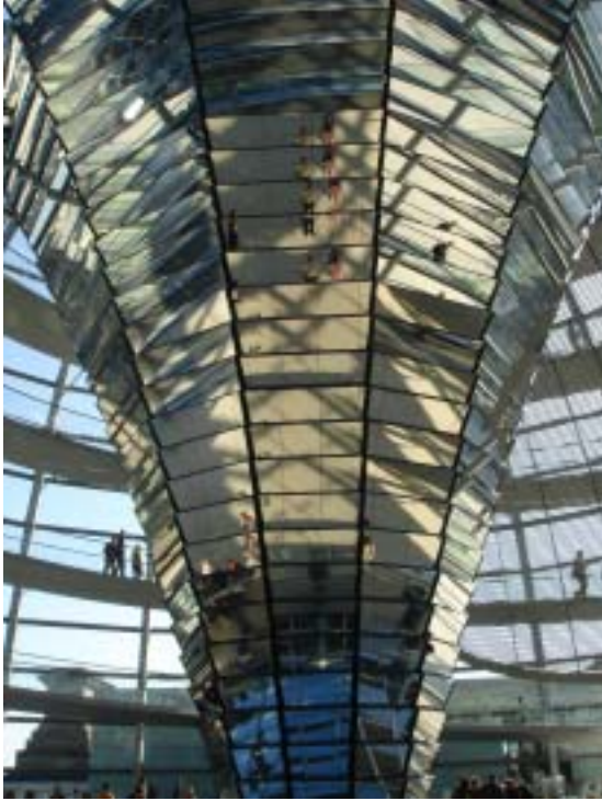
圖 3-12 貼滿鏡子的圓錐體將室外光線反射到室內
