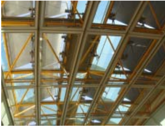
圖 3-17 薄膜結構之鋼架
