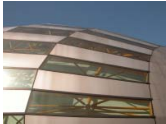
圖 3-18 雙層薄膜結構之外層結構
