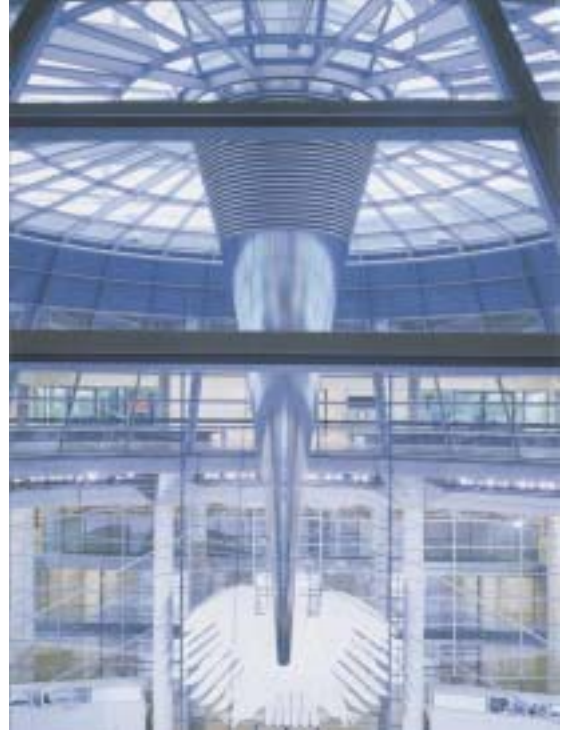
圖 3-13 透明採光大幅減少人工光源及用電量
