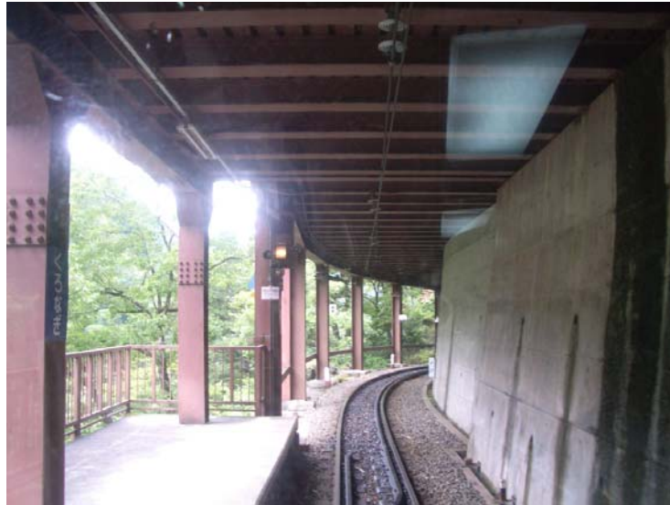
照片 16 黑部鐵路防護山壁崩塌之安全設施
