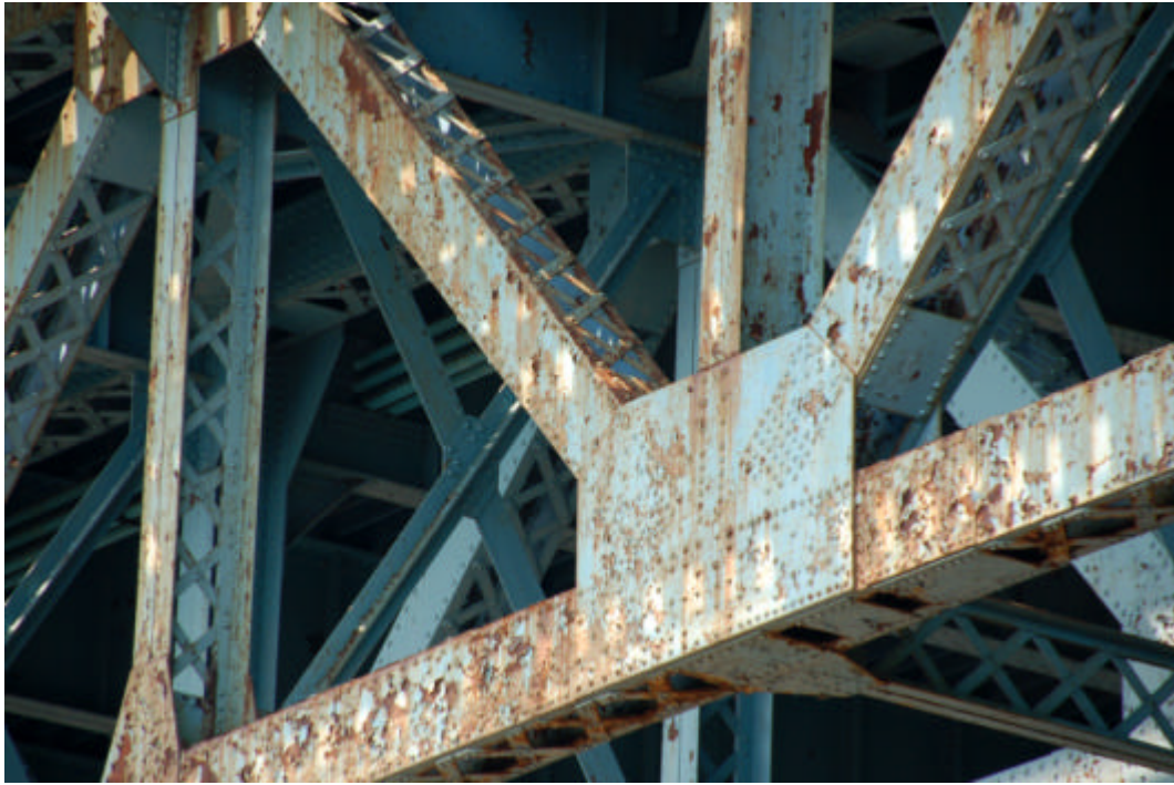
圖 2.19 鋼橋的鏽蝕
