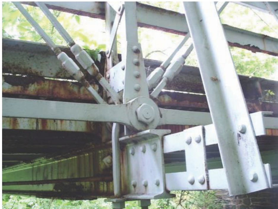
圖 2.11 下弦桁架接合點及橋板接合點
