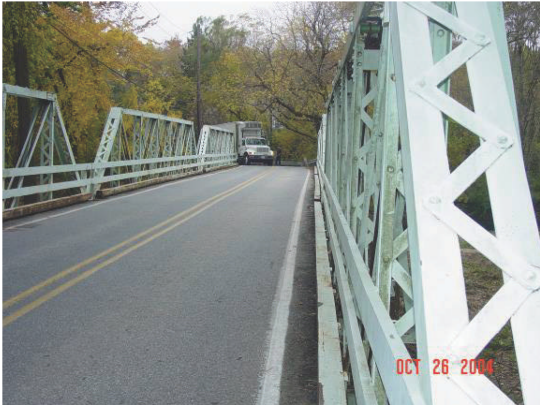
圖 2.10 橋梁現況照片
