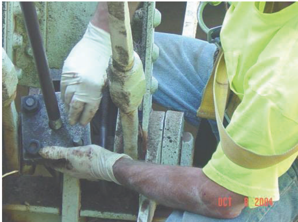
圖 2.14 補強對角桿件安裝情形
