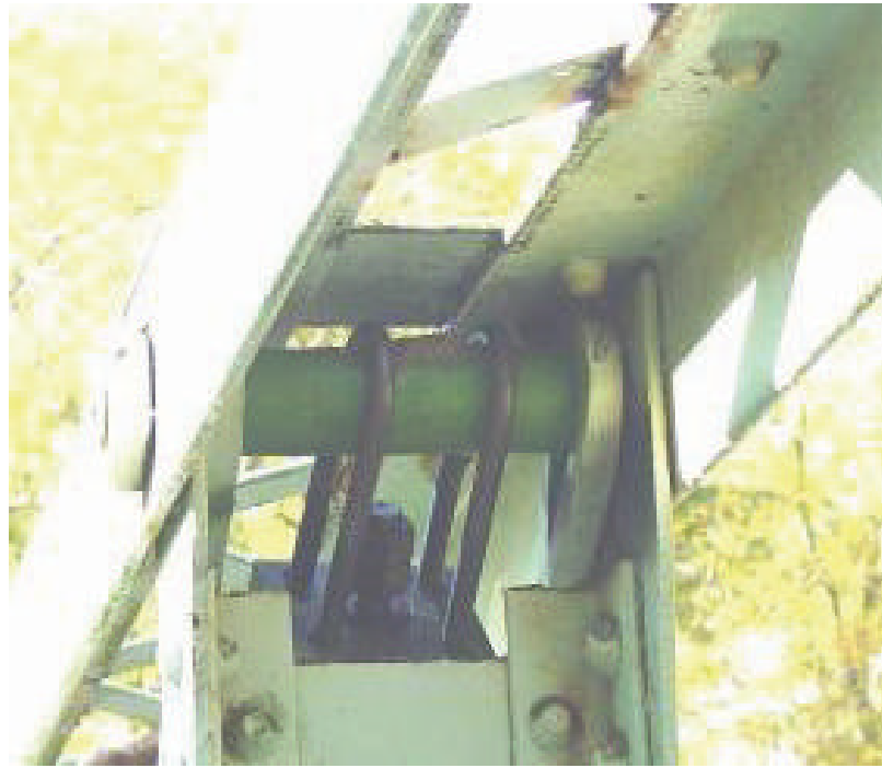
圖 2.13 補強對角桿件示意
