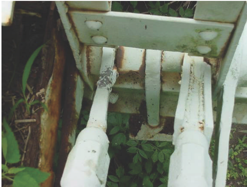
圖 2.12 以往在拉桿加鉚鋼板用來補強接頭
