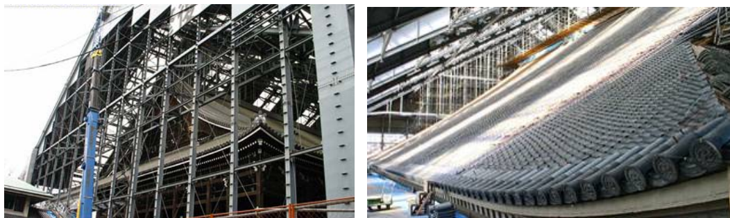
西本院寺修復工程
