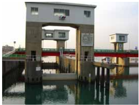
圖 56 吉野川河口堰示意 (左側為魚道(1) 中間為航運之閘門(2))
