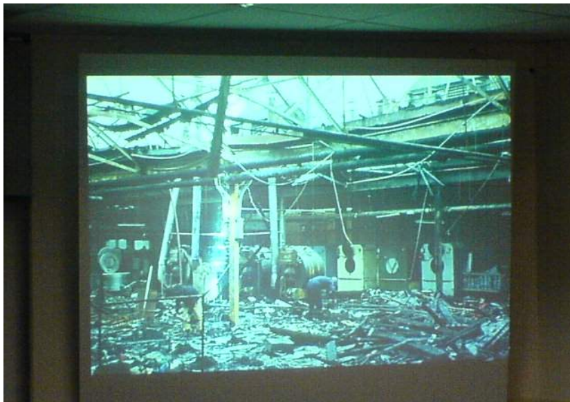
【照片 13】這是發生在洗衣店的火警，鋼架、水管、還有披覆開始掉落，就某些衣物來說剛被烘完是容易起火燃燒的，例如美容院使用的毛巾，就是屬於這類。
