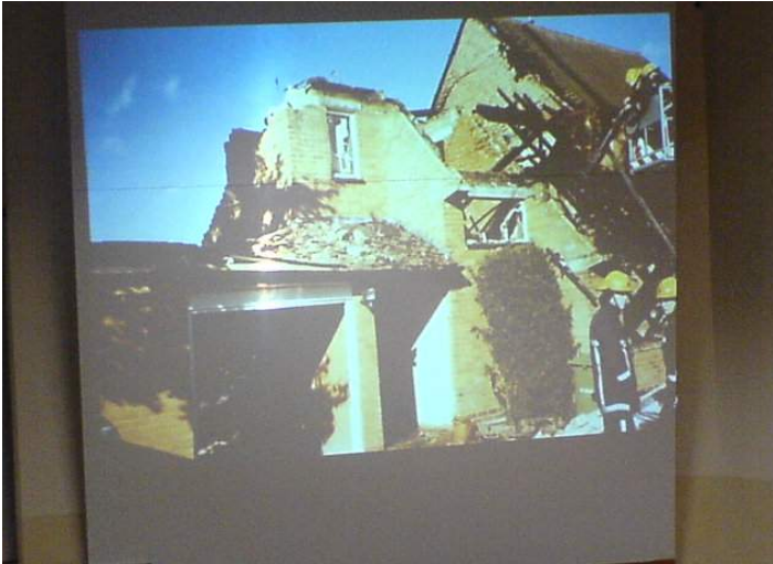
【照片 2】現場燃燒後狀況。
