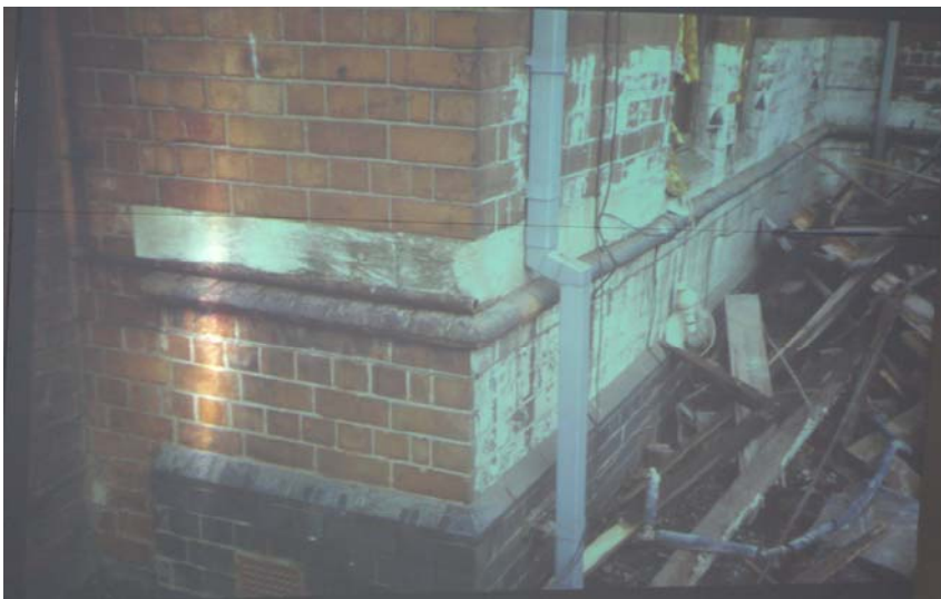
【相片 65】經過證實並未弄斷任何管線,部分瓦斯管線消失。原因是原本要移除油管，後來不慎也移除瓦斯管線。雖然死者經常評論共和軍，不過這是件意外。
