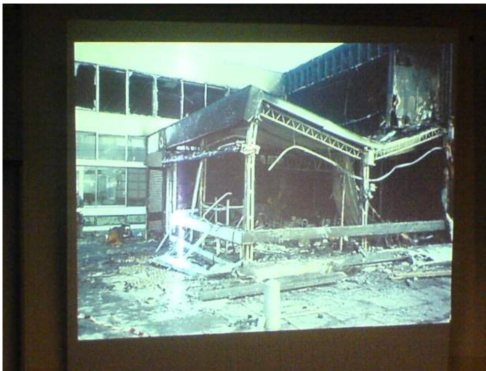
【照片 19】這張圖示典型結構倒塌，前方中間的鐵柱被燒的嚴重，研判應該是在左側中間的房間被縱火，是使用亮光劑，是兩個青少年縱火。
