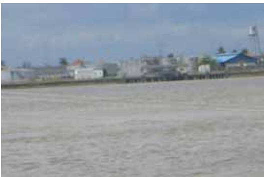
圖十三、湄公河岸油槽區照片
