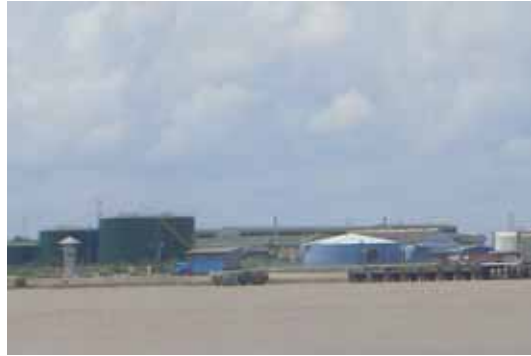
圖十二、湄公河岸油槽區照片
