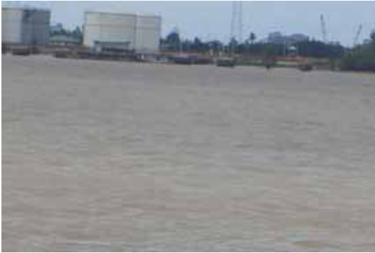
圖十一、湄公河岸油槽區照片
