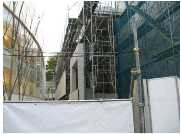
照片 27 標準之門型施工架(東京都)
