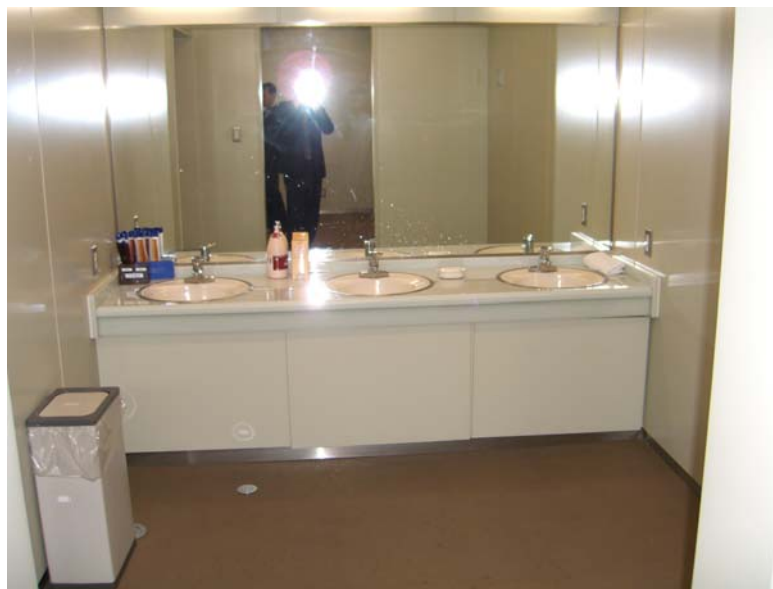
照片 11 日本變電所設置預鑄型洗手台
