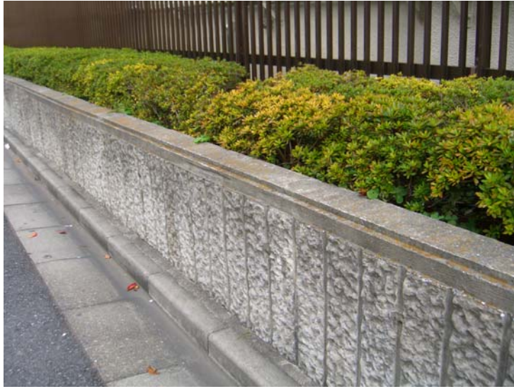
照片 19 採用造型模板構築之花台
