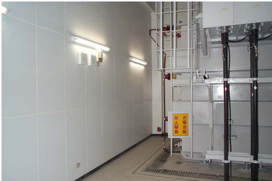
照片 14 豐華一次配電變電所變壓器室牆面裝貼吸音板
