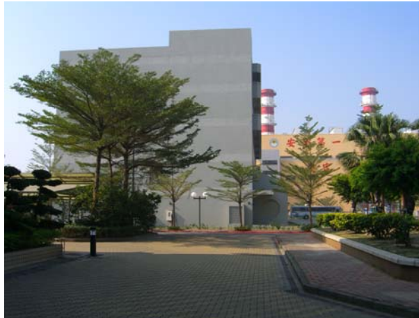
照片 4 鎮北一次配電變電所透水鋪面
