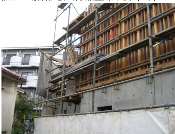
照片 22 採用清水模板施工之日本民宅
