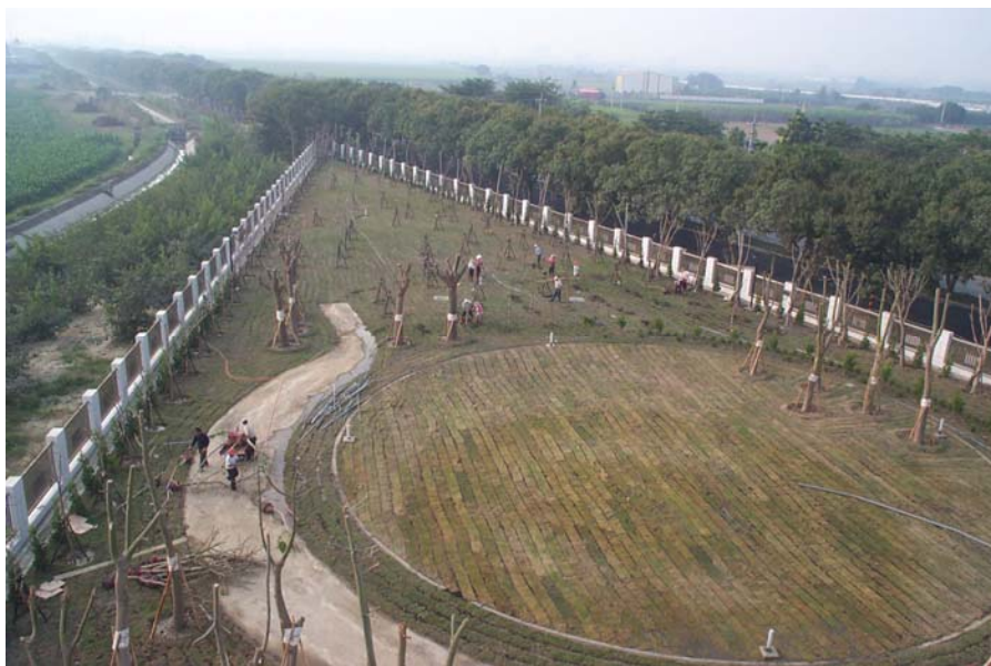
照片 2 柳營一次配電變電所綠化鳥瞰圖
