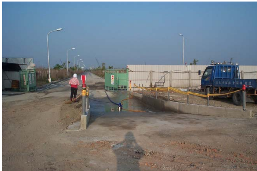
照片 13和順一次配電變電所設置污染防制措施-洗車池
