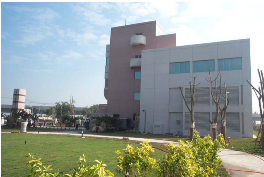
照片 1 柳營一次配電變電所綠化景觀
