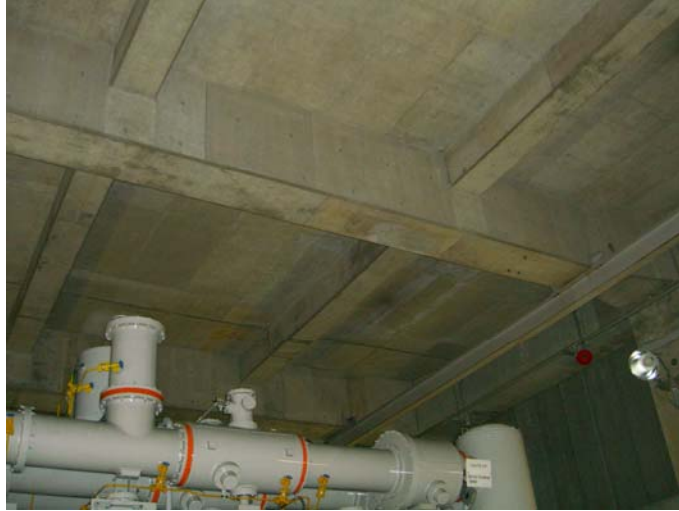
照片 18 日本室內變電所採用清水模板構築梁板
