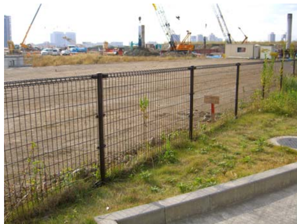
照片 21 美觀粉體塗裝鏤空圍籬〈新豐洲變電所〉
