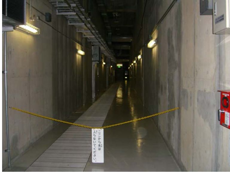
照片 12 採用清水模板之日本室內變電所
