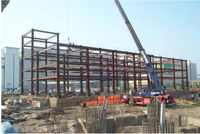
照片 8 豐華一次配電變電所使用製程產生最少 CO 2 之鋼構架
