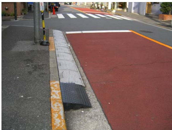
照片 20 鋪設彩色瀝青混凝土路面之東京街景
