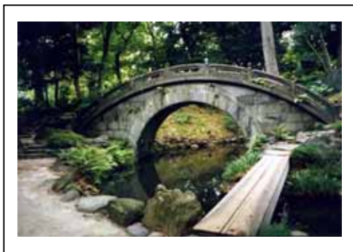
圖 65【小石川後樂園】拱橋
