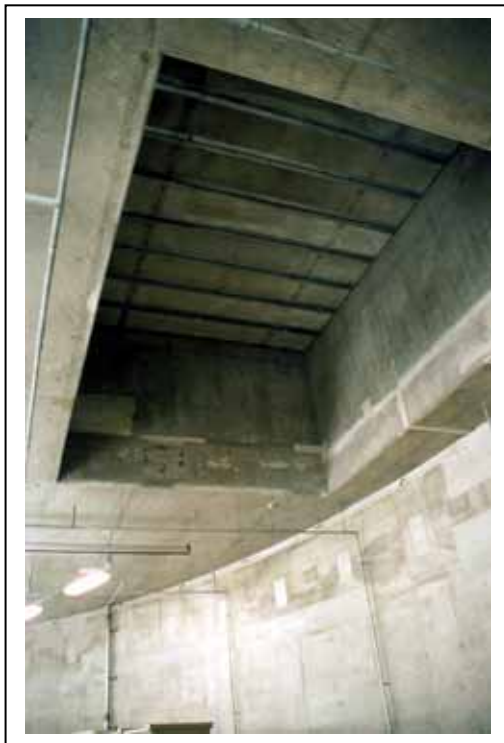
圖 11【A】中央變電所供施工維修開孔
