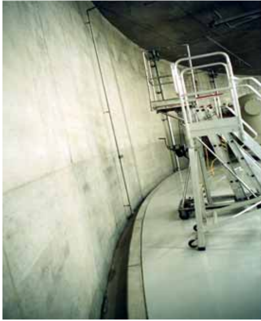
圖 9【A】中央變所電連續壁和外牆
