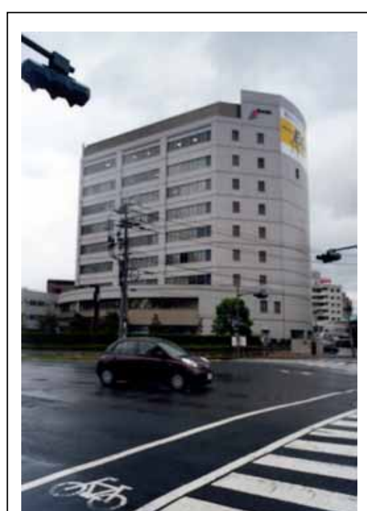
圖 8【A】中央變電所實況外觀照片
