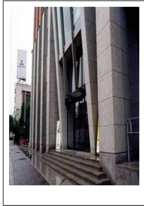
圖 28.【B】小網變電所正面進口
