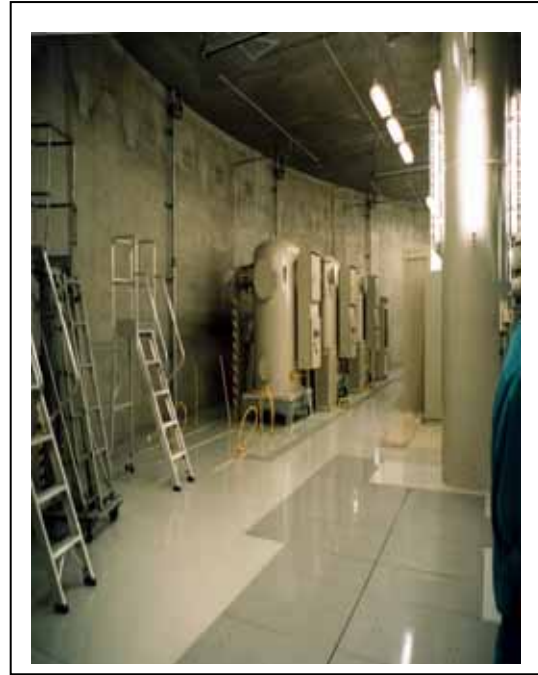
圖 10【A】中央變電所連續壁和外牆
