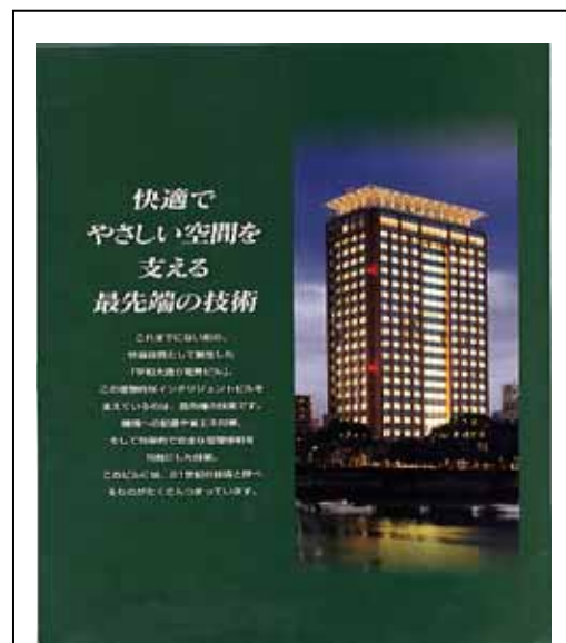
圖 22. 【B】小網變電所夜景
