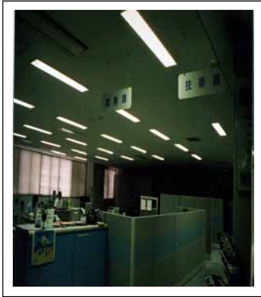
圖 17【A】中央變電所地上層辦公室
