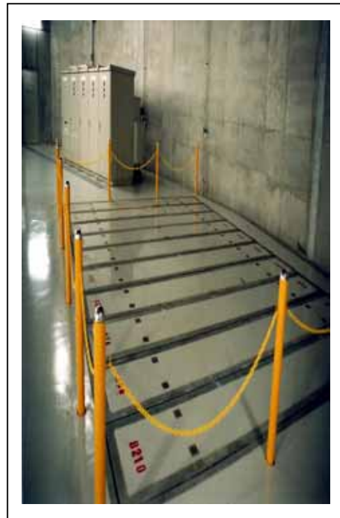
圖 12【A】中央變電所施工維修開孔
