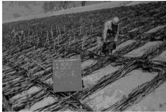
打樁編柵施工情形1
