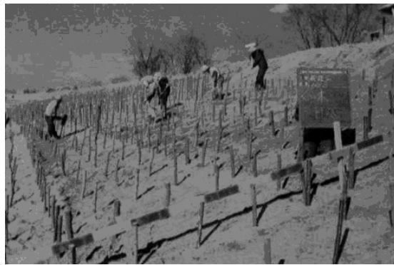
打樁編柵施工情形2
