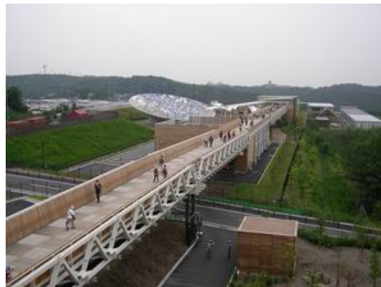
照片 30 會木材鋪面天橋
