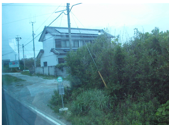
照片 18 住宅裝設太陽能發電設施
