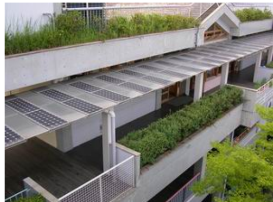
照片 16 裝置太陽能板的屋頂
