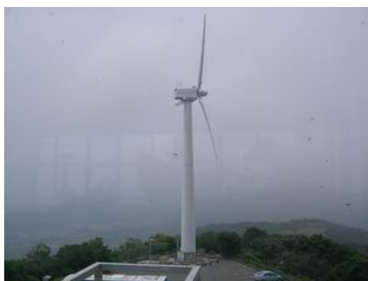
照片 19 藏王山展望台風力發電機
