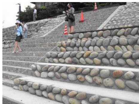
照片 6 長良川右岸階梯式的河岸護坡
