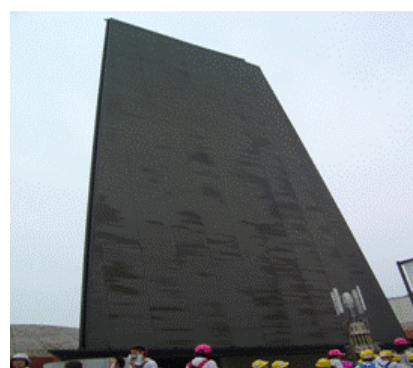
照片 24 利用光催化劑鋼板的建築物
