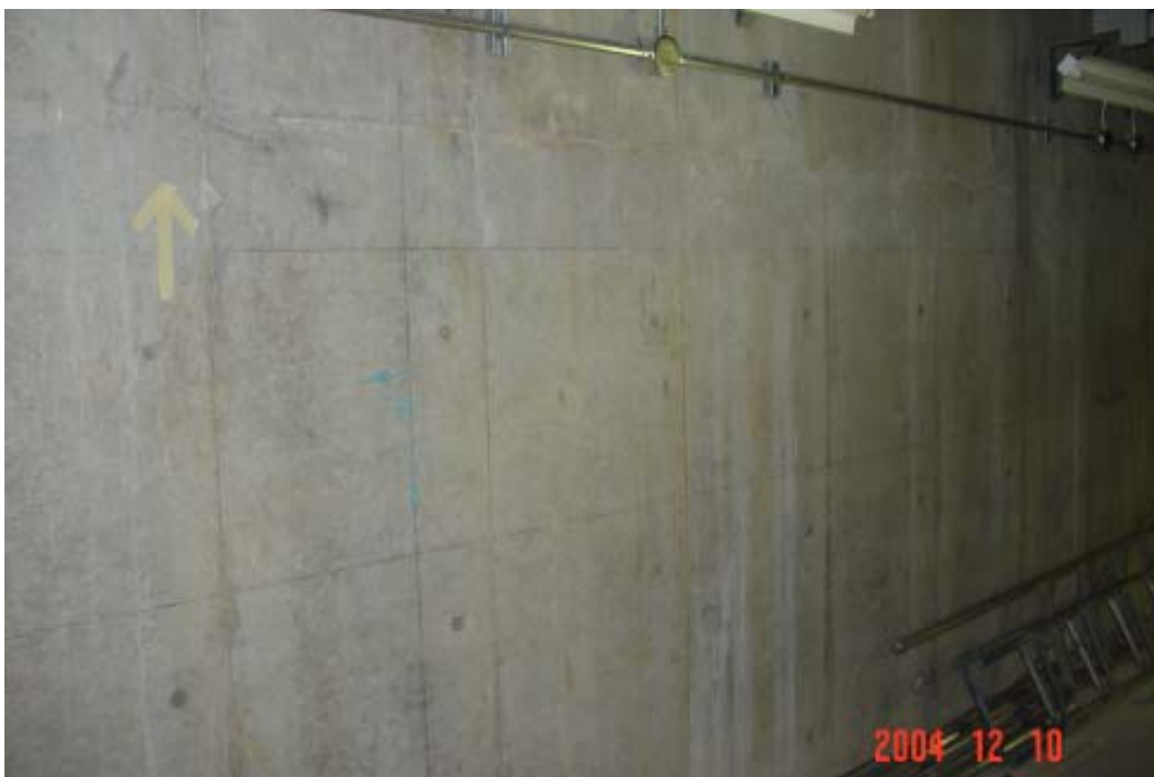
參觀志賀核能電廠 2 號機結構牆面優良施工品質一景
