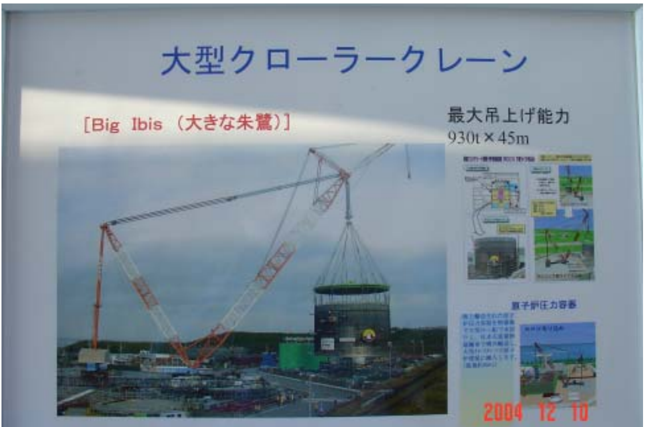
利用大型吊具進行區塊設備組裝施工情景
