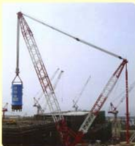
原子炉圧力容器据付
