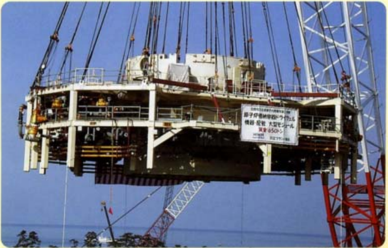
利用大型吊具進行區塊設備組裝施工情景
