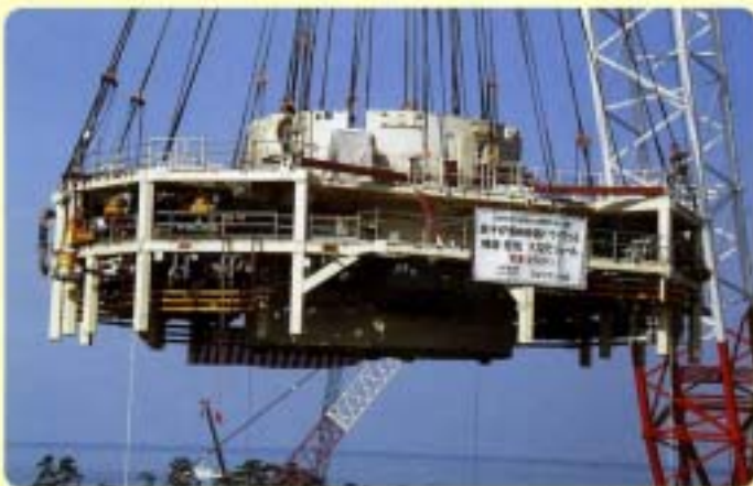
原子炉格納容器 ドライウェル機器・配管大型モジュール据付
