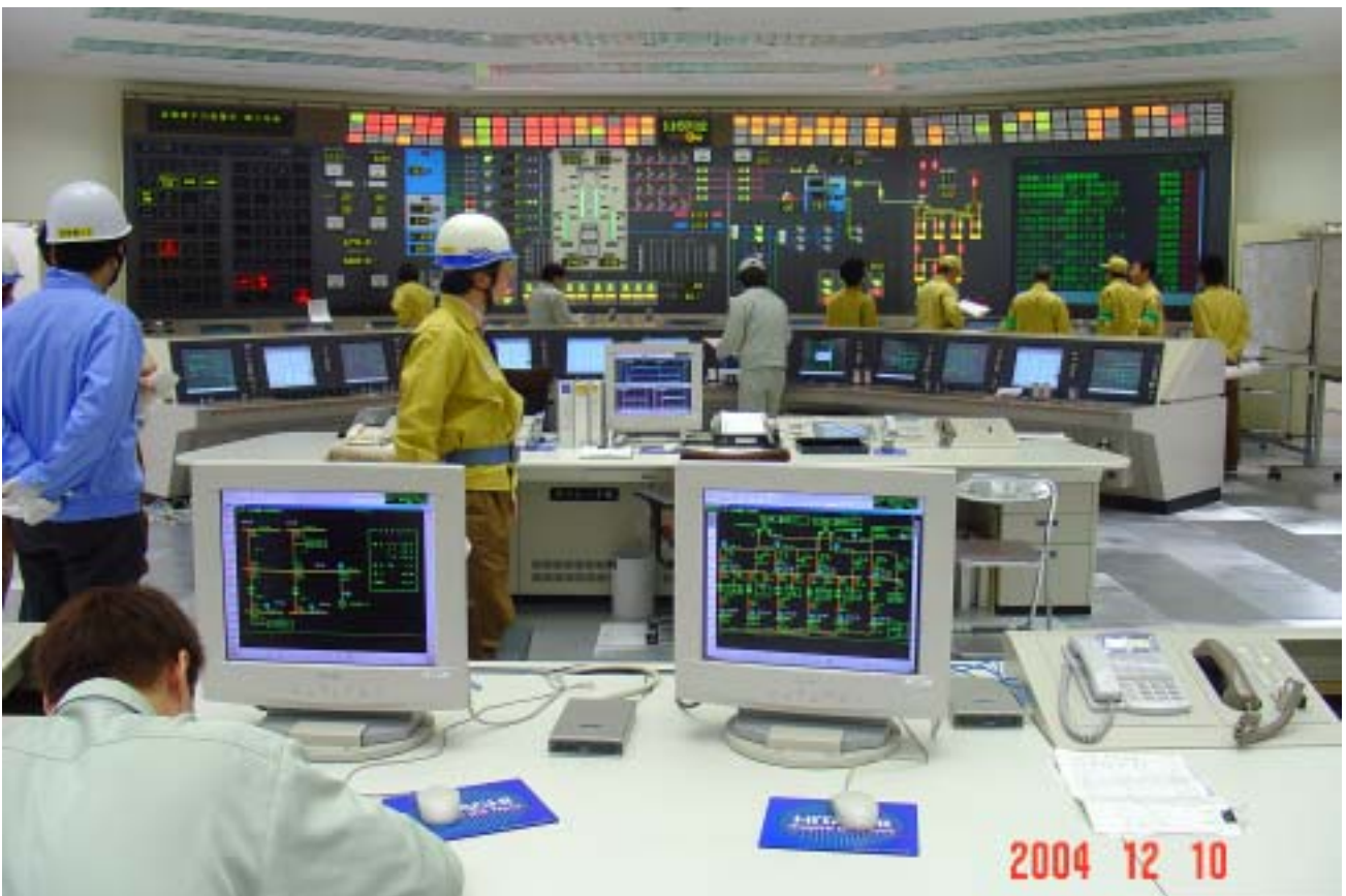
參觀志賀核能電廠 2 號機控制室日立公司與電廠運轉員進行系統測試作業情景
