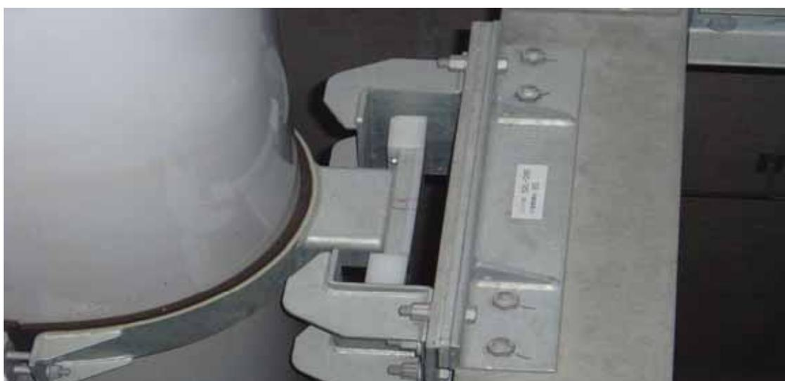
圖四 東海變電所內 Shinmekia Tokai 275kv 線 GIL 固定座(垂直段)
