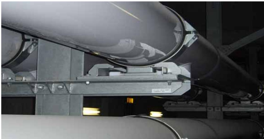
圖三 東海變電所內 Shinmekia Tokai 275kv 線 GIL 固定座(水平段)
