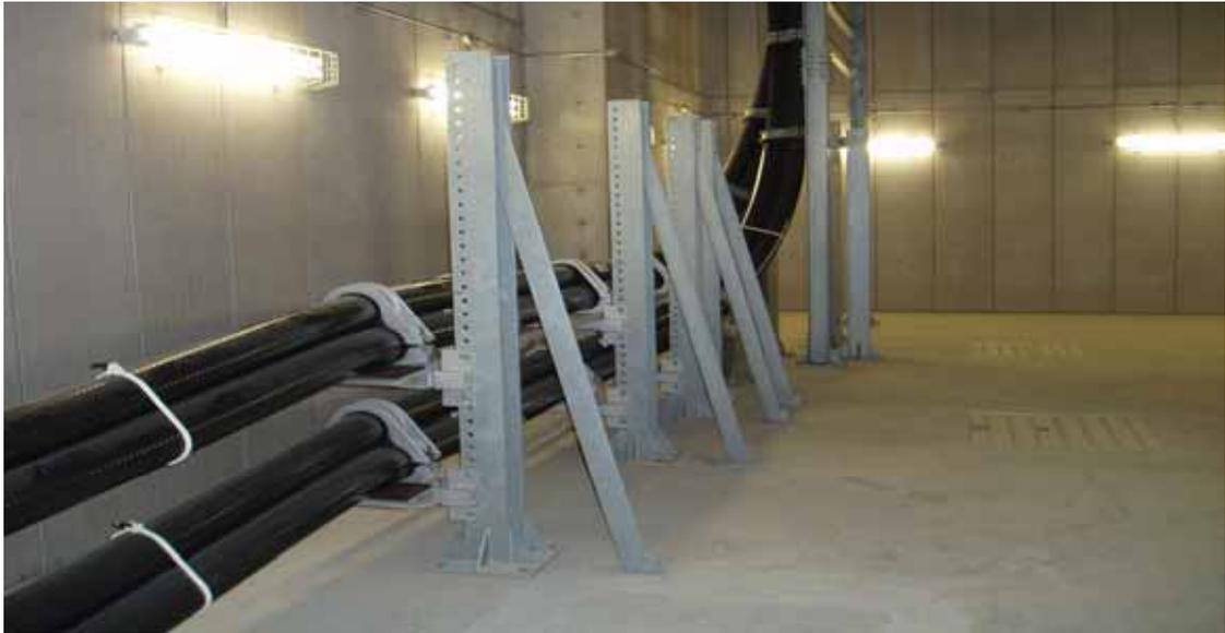
圖十 Spring type cable cleat(二)
