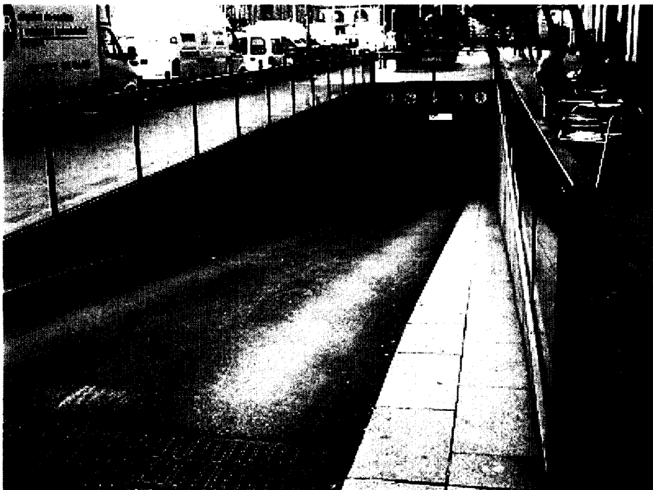
圖 3.4-4 路外停車場入口(兩側附設行人道)
