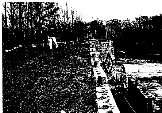
相片八 加勁路堤
