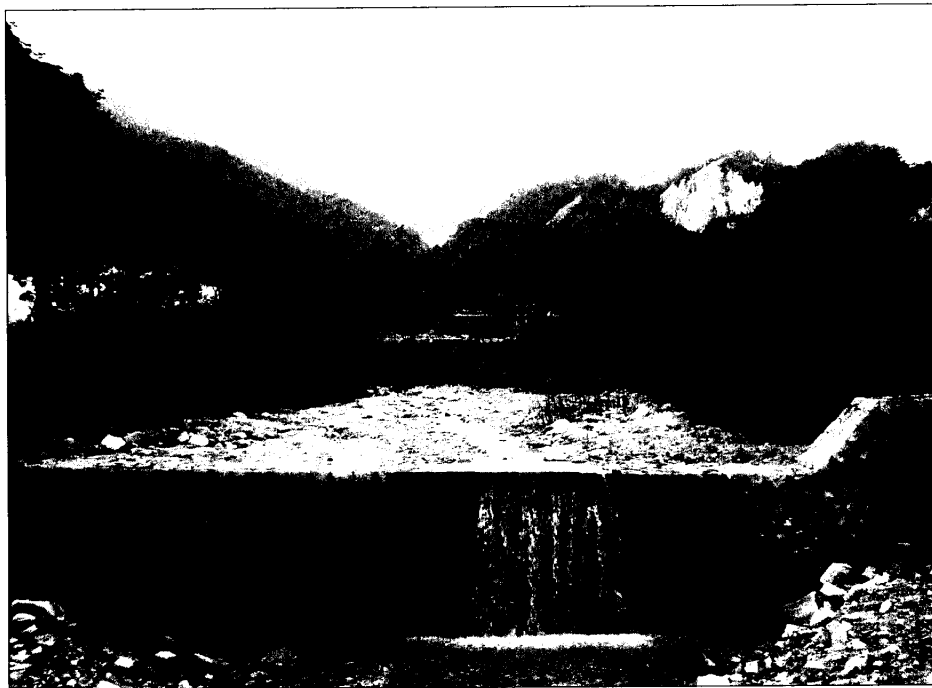
圖 4.3.3 座頭谷川上游攔砂壩與崩塌地
