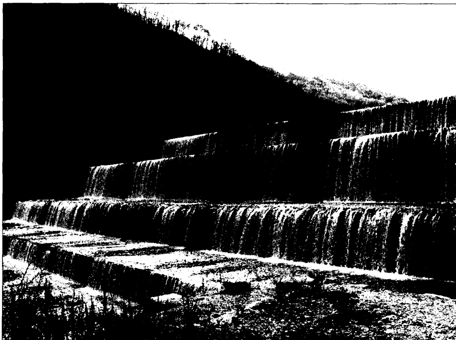
圖 4.13.5 平川之橫溪防砂堰堤
