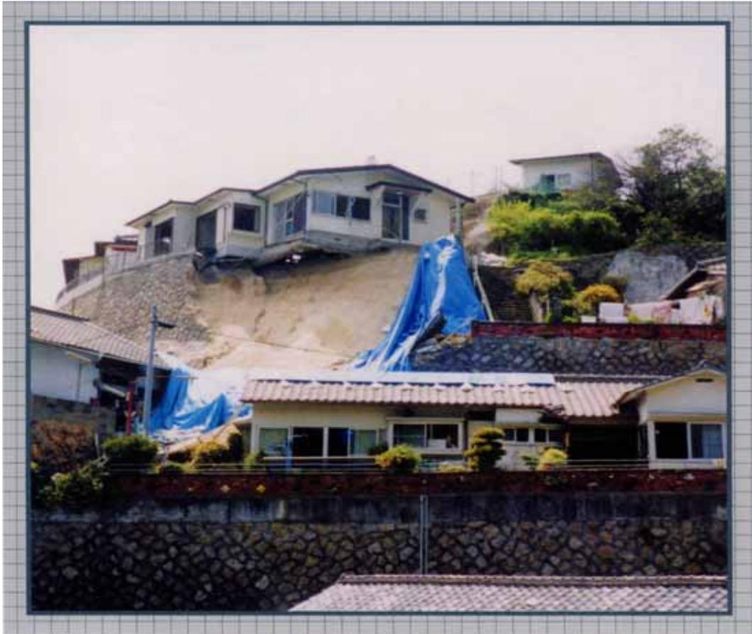
圖 4.12.2 因地震造成陡峭邊坡崩塌
