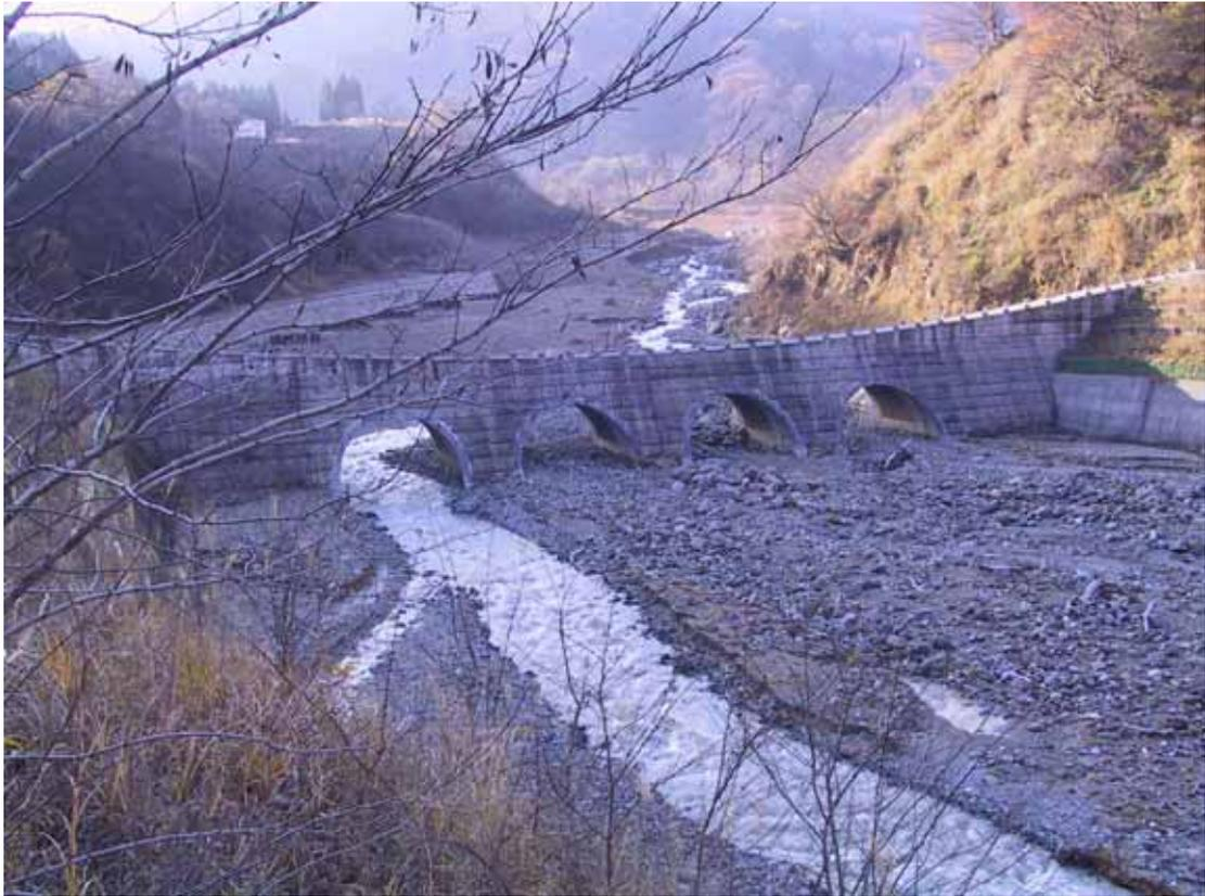
圖 4.13.8 浦川暗渠砂防堰堤
