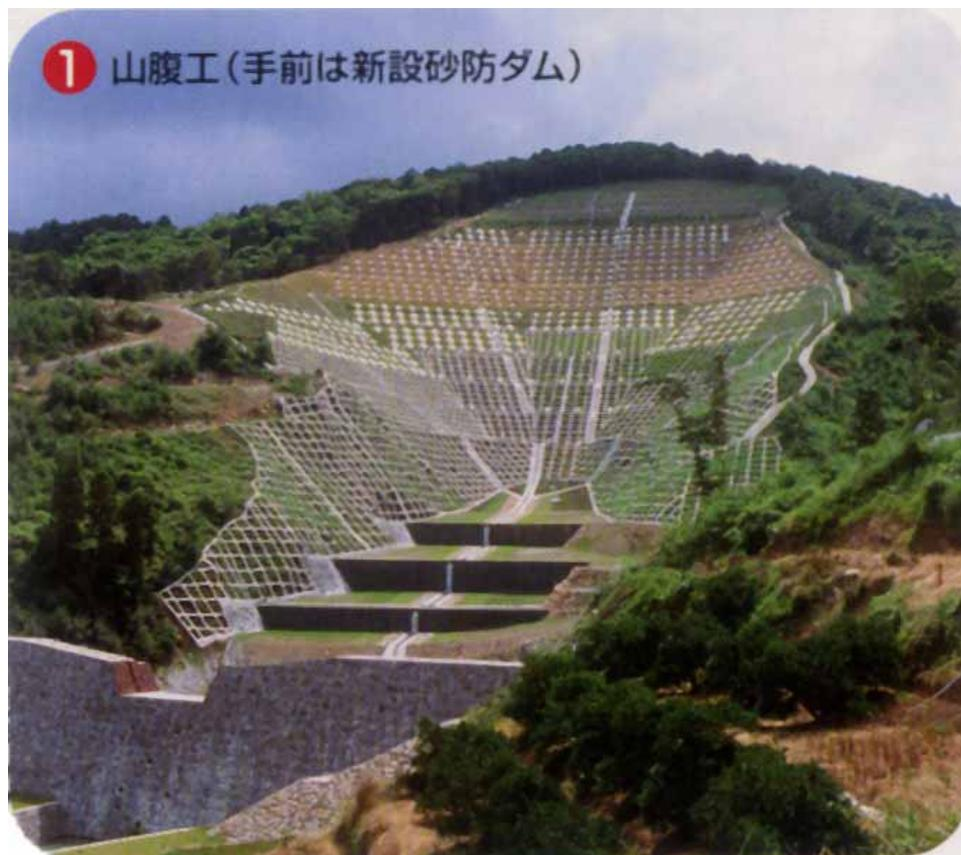
圖 4.7.4 崩塌邊坡整治後之全景
