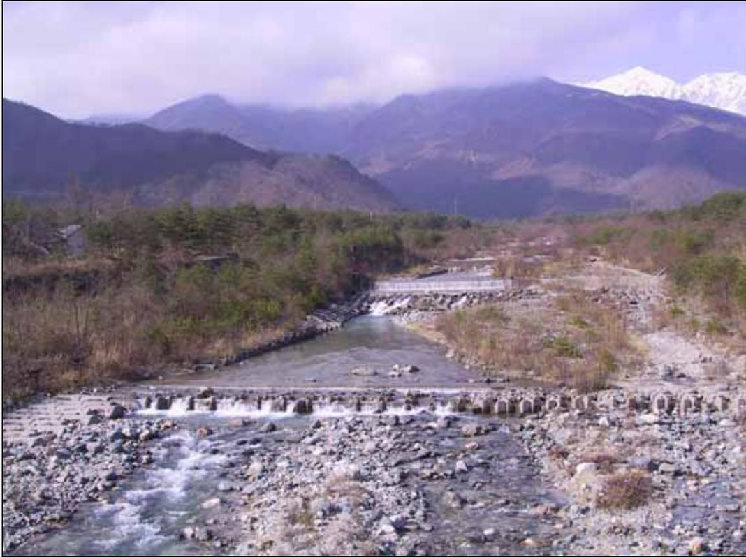
圖 4.13.4 平川之固床工、護岸情形
