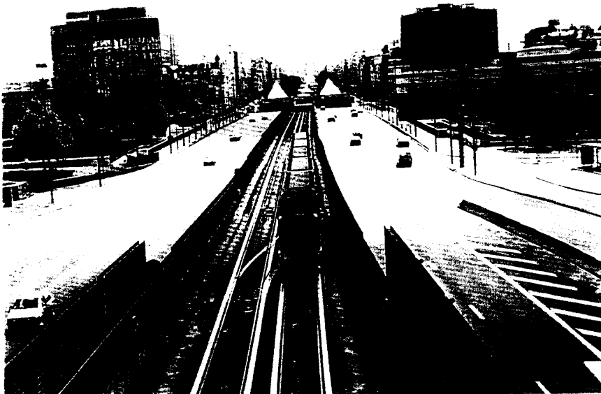
圖 4.7-12 進入拉德芳斯車站地區之軌道
