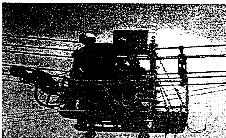
- Spacer-Car : 2導體用 電線 Spacer-Damper 點檢 補修用
