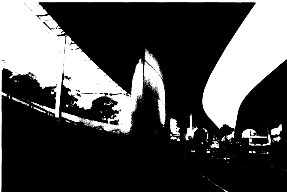
照片 50. 橋柱外側搭配橋下空間及人行步道作導流配設
