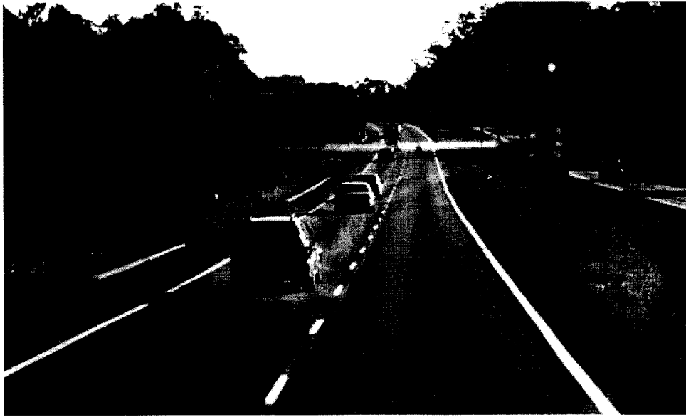
照片 35. 高速公路速限以 100 km/hr 為原則
