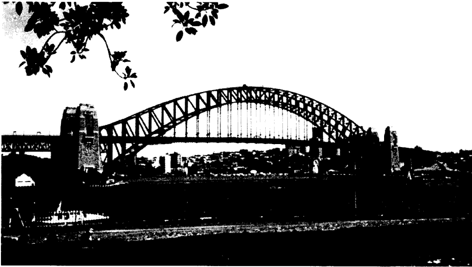
照片 2. 雪梨港灣大橋之桁架結構
