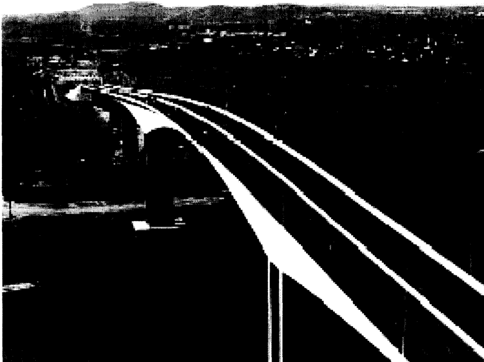
照片 13. Gateway Bridge 橋寬 22m 梁深 15 m
