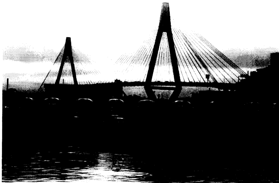
照片 9. ANZAC Bridge
