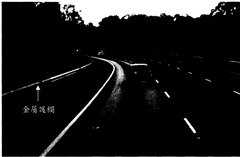
照片 41. 路堤段外側 W 型金屬護欄
