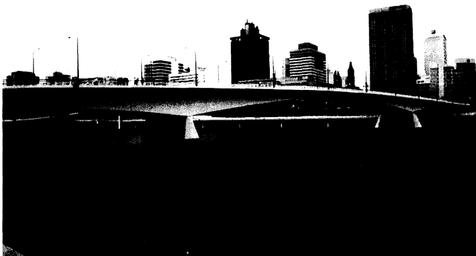
照片 17. Victoria Bridge
