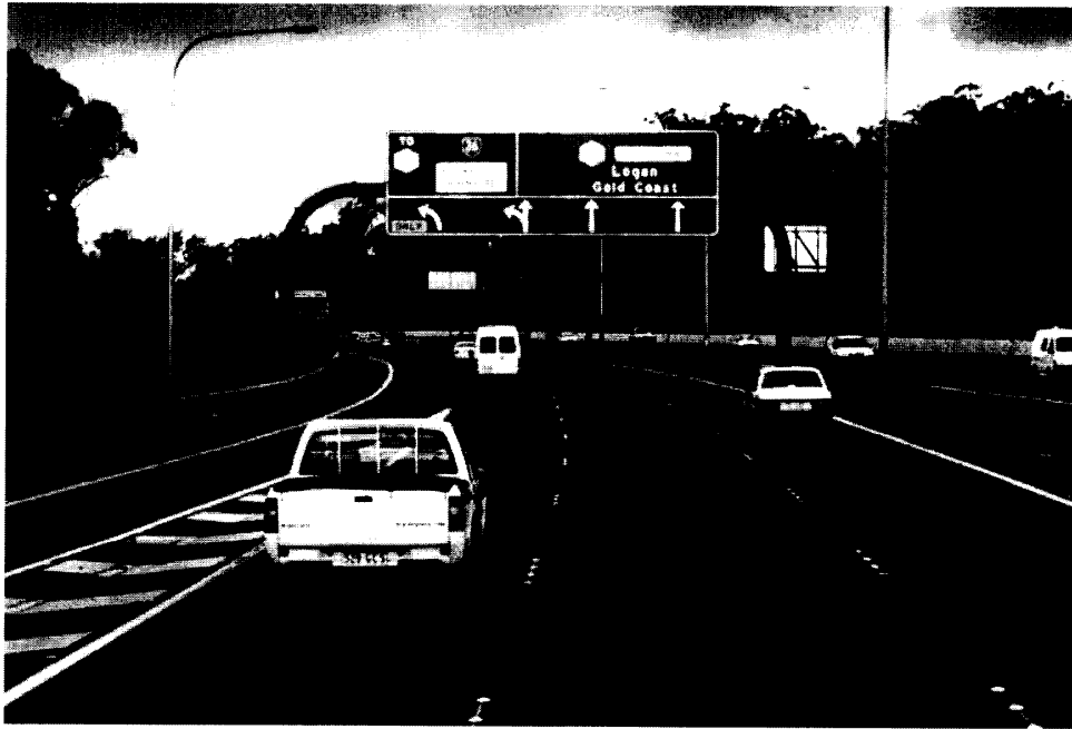
照片 45.標誌鋼構架桿件簡潔
