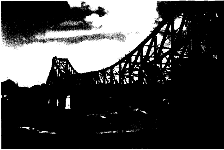
照片 15. Story Bridge 側視
