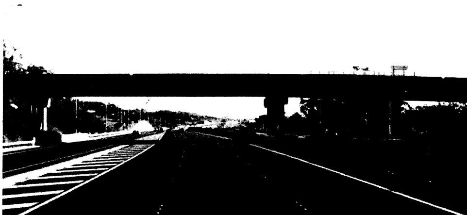
照片 21. Highway 橋梁以簡單 PC 梁橋居多
