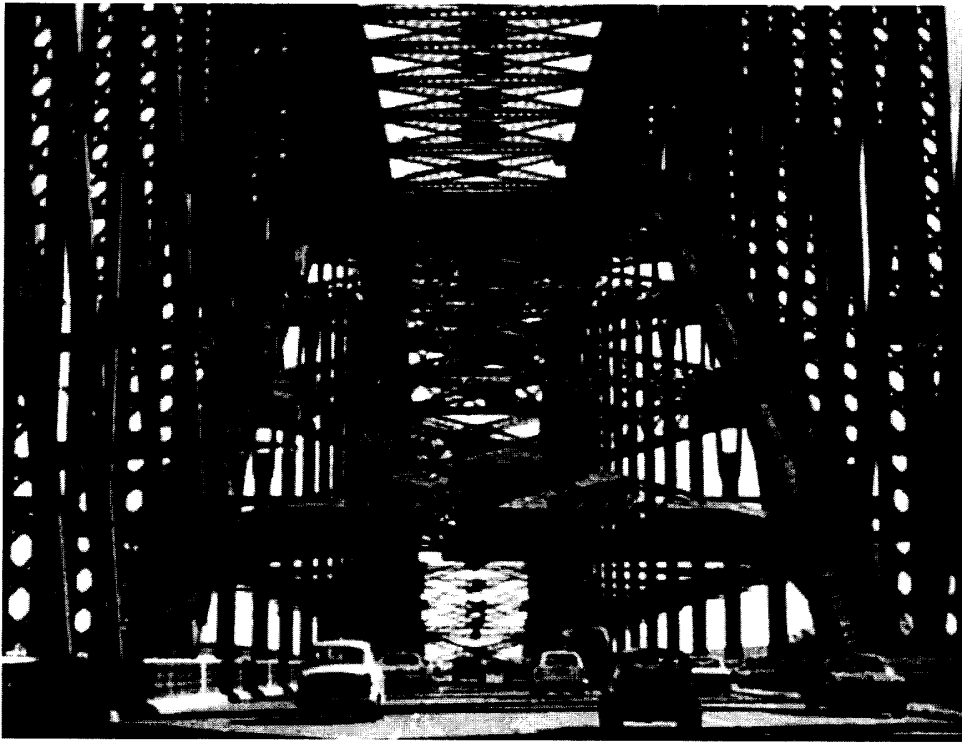
照片 3. 雪梨港灣大橋之水平桁架結構
