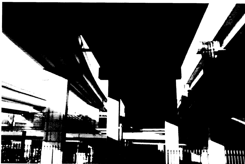
照片 22. 立體交叉橋梁採鋼鈹梁型式
