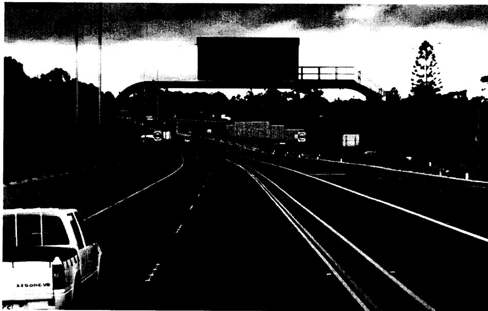
照片 46. CMS 鋼構架桿件簡潔
