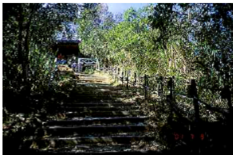
圖 38 步道沿線水源及電力管線
