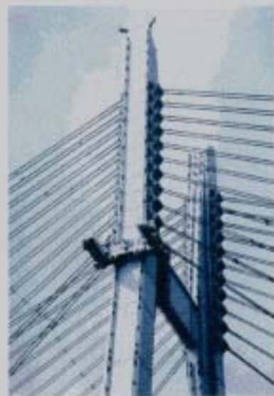
「塔外面作業車での点検」
