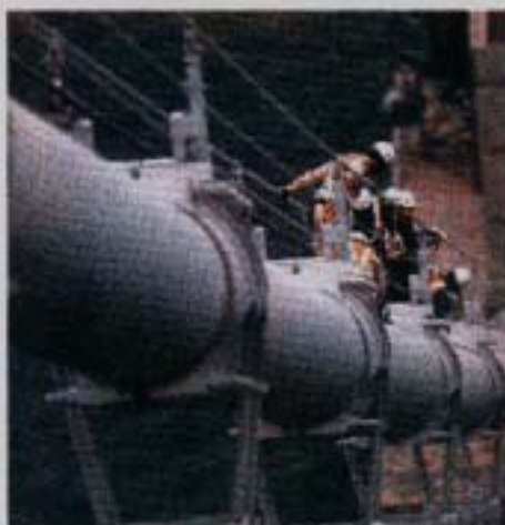
＜写真＞瀬戸大橋パンフ「ケーブル上の点検」
