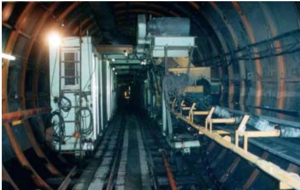
照片十七、TBM 使用輸送帶直接出碴至隧道外照片
