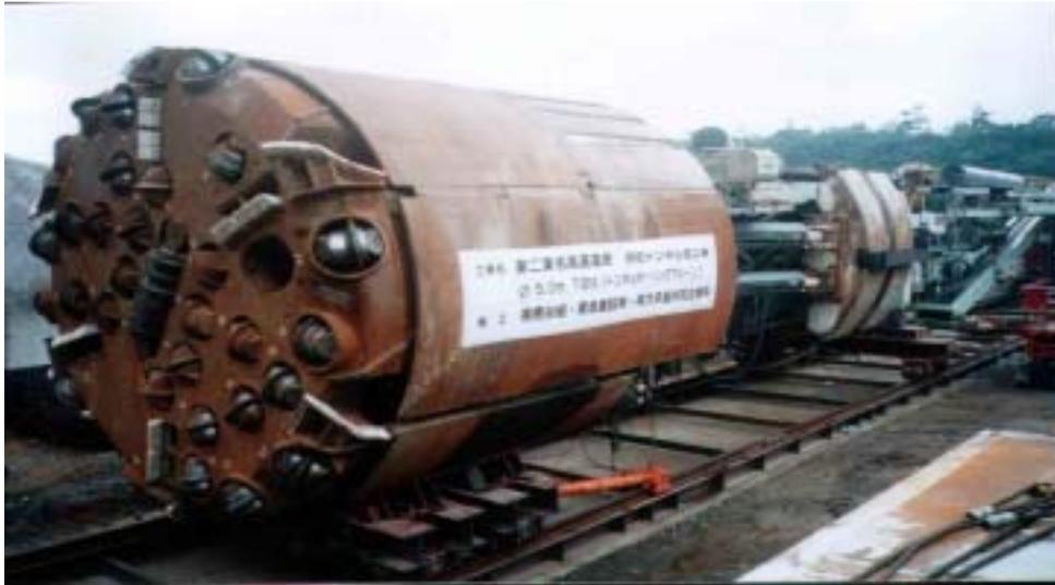
照片一、TBM 機身於 松隧道外組裝情形
