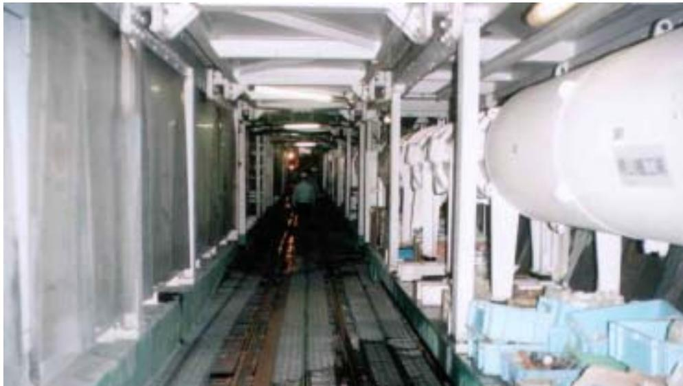
照片八、引佐隧道 TBM 後方支援系統照片
