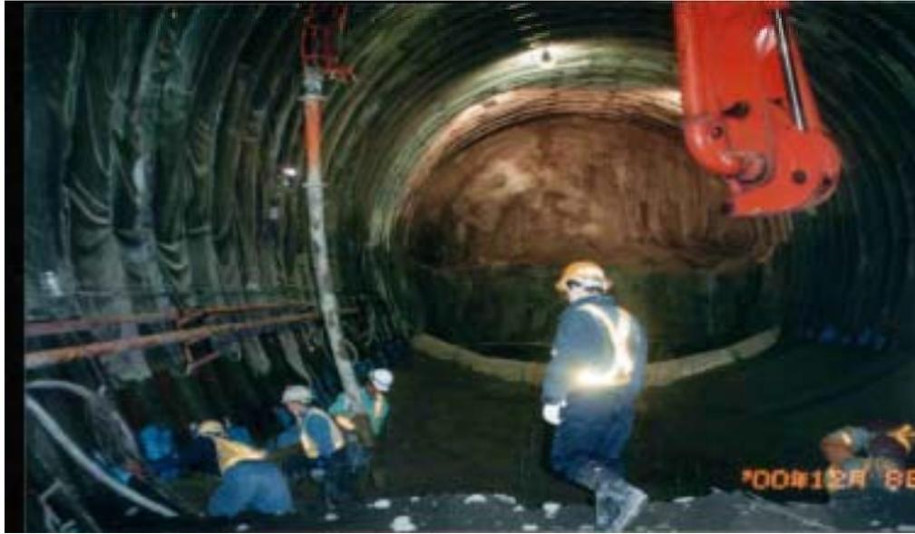
照片六、富倉隧道仰拱混凝土澆置情形
