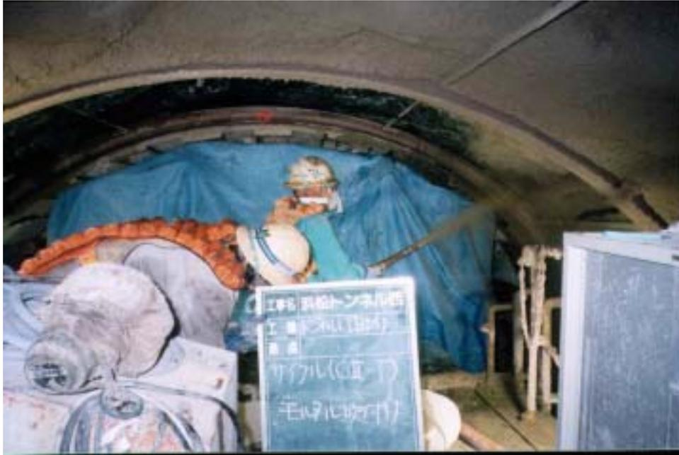
照片十五、噴凝土施工照片
