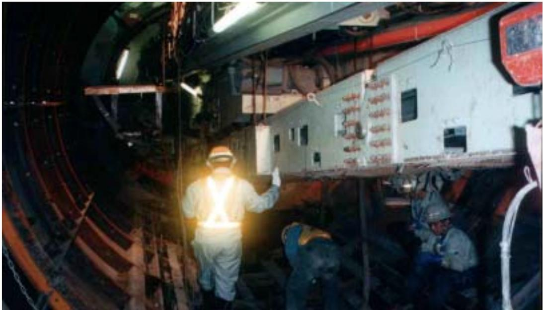
照片十一、富士川隧道現場鋼支保架設施工照片
