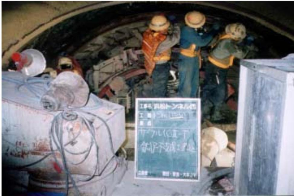
照片十四、鋼支保架設施工照片
