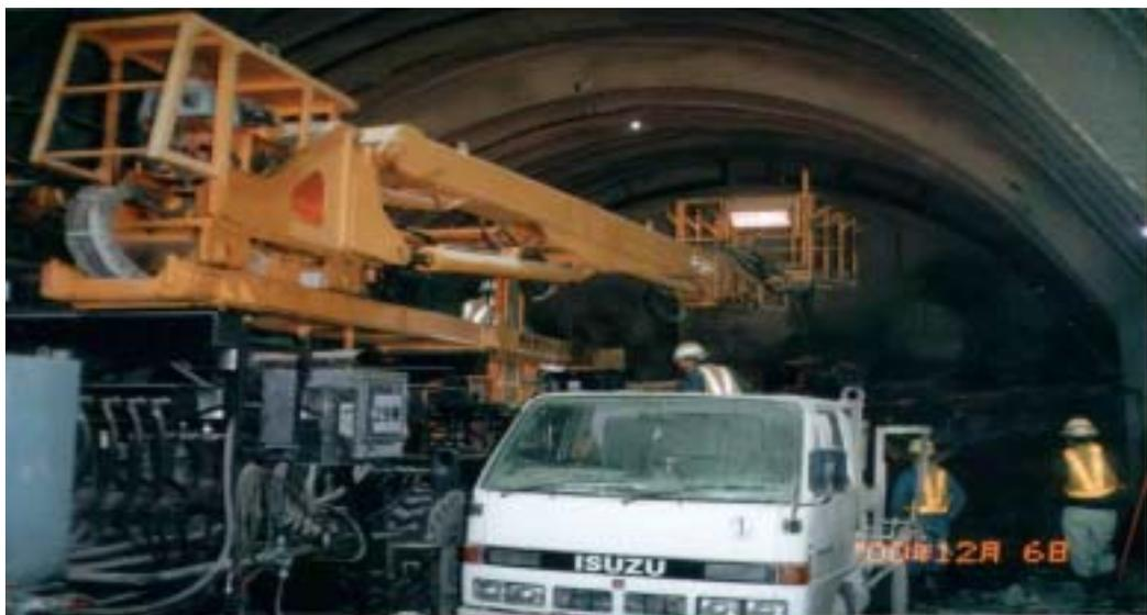
照片五、箕面隧道噴凝土施作情形
