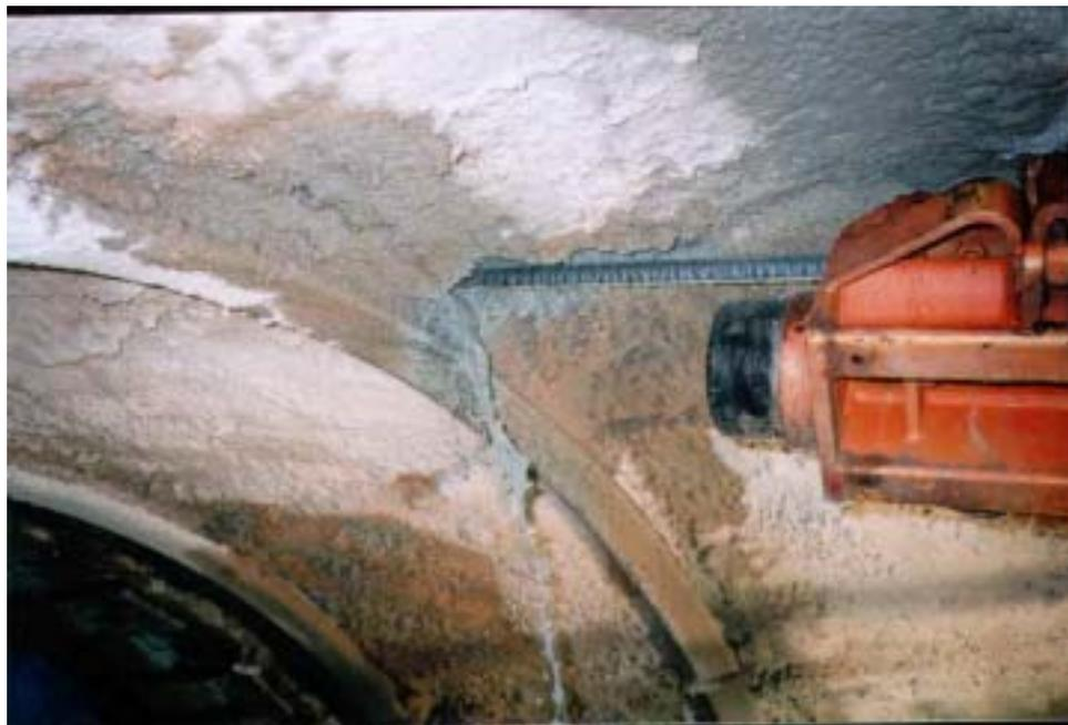
照片十六、前進鑽機施作先撐鋼棒之情形
