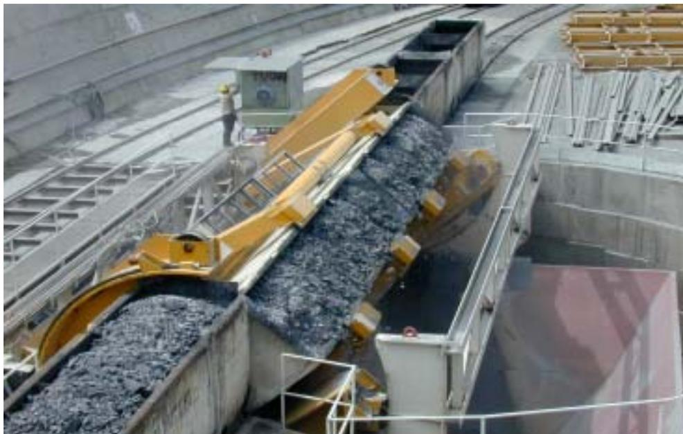
照片十九、旋轉傾倒渣料設施照片
